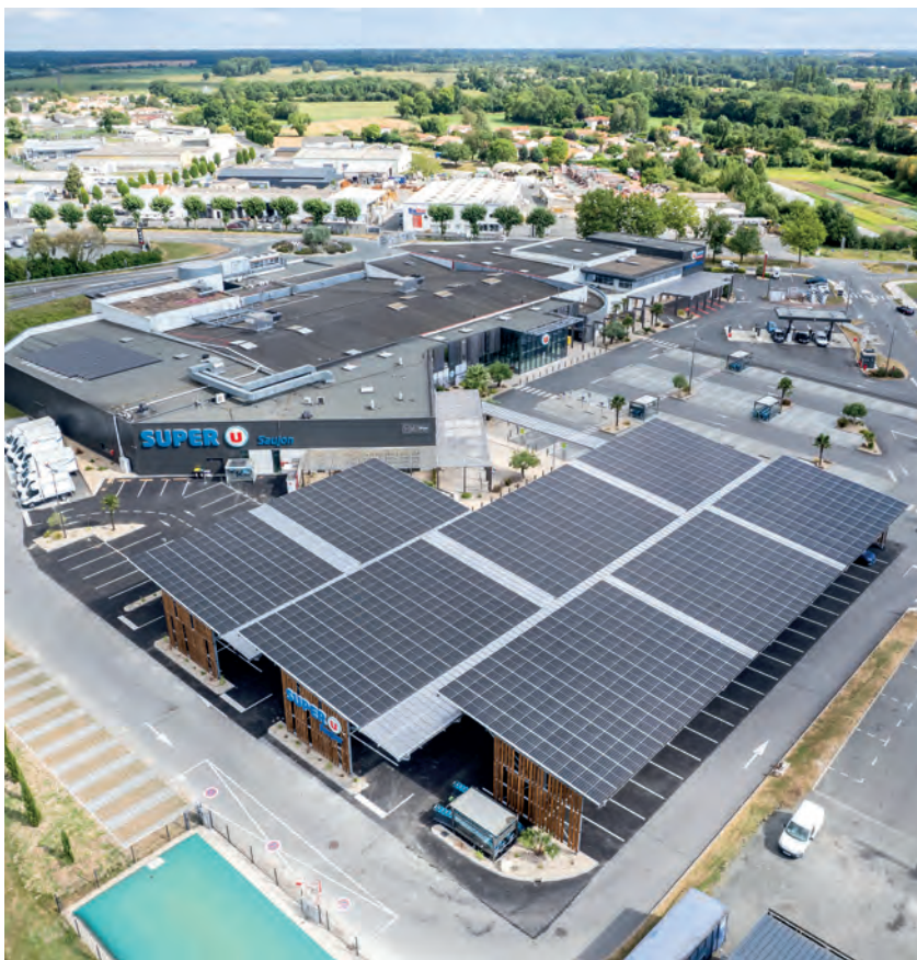
Lampes Led, panneaux photovoltaïques et système de réfrigération à partir de gaz CO2 ont permis au Super U de Saujon de réduire de moitié son empreinte carbone.
