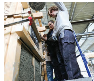
Au lycée de l'Atlantique, atelier d'isolation de murs en béton de chanvre réalisé par des élèves en rénovation du patrimoine bâti.
